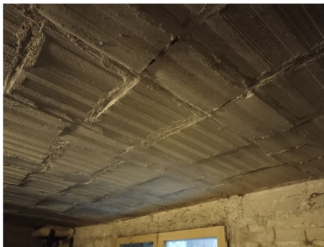
Immagini: solaio di piano realizzato in latero cemento, individuazione del verso dell’orditura dei solai.
