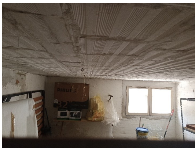
Immagini: solaio di piano realizzato in latero cemento, individuazione del verso dell’orditura dei solai.
